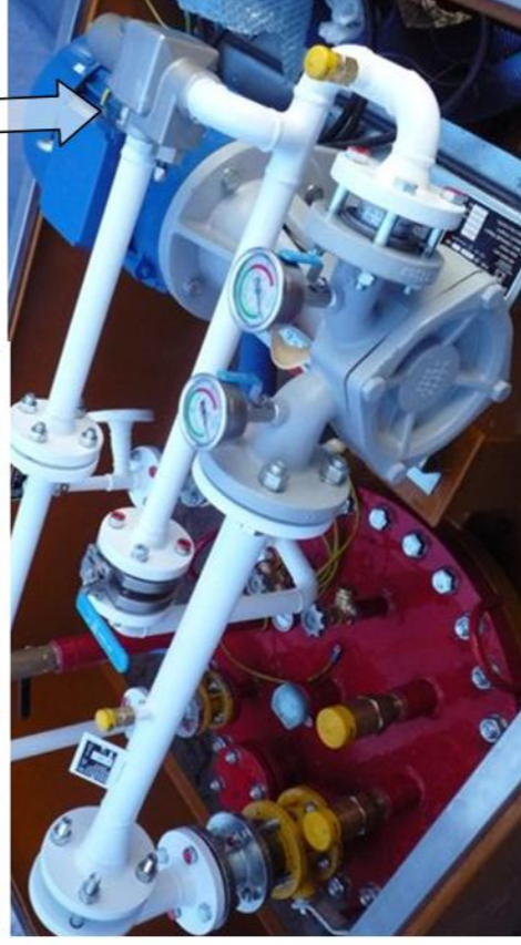
zawory ZPG wykonane są ze stali nierdzewnej
